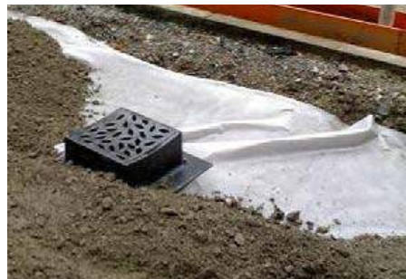
Luftigt bärlager utlagt kring luftbrunn. Geotextil läggs ut innan samkross och beläggning påförs. (Foton: Björn Embrén)
