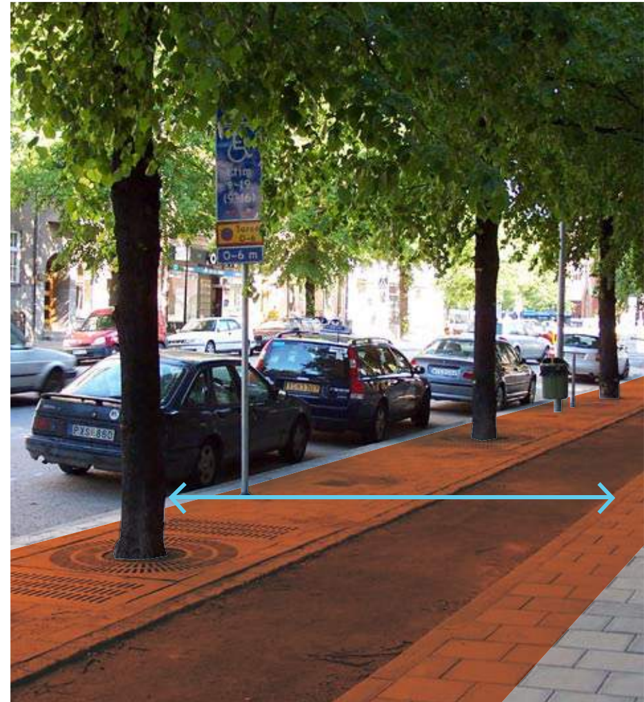
Återställning av nytt ytskikt med betongplattor. Ram för trädgaller läggs på betonglåda eller betongsylar. Den färdiga anläggningen har en rotningsbar växtvolym på 15 m 3 per träd. Orange fält illustrerar ungefärlig bredd på det sammanhängande skelettjordssträket. (Foton: Björn Embrén)
