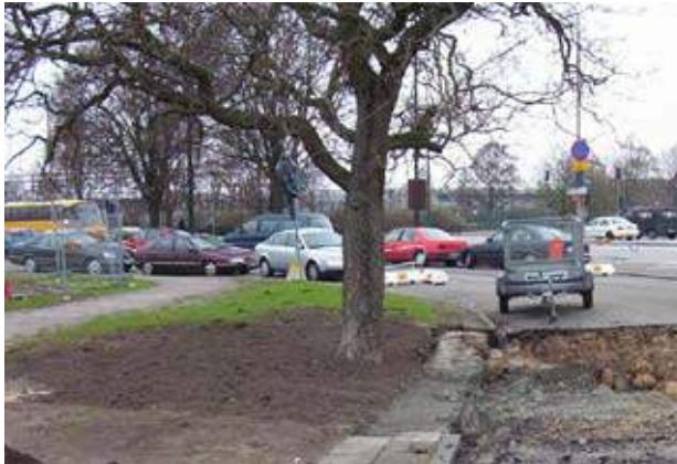
Befintliga hagtornsträd i Malmö vid en gammal väg. Vägen ska tas bort och ett sammanhängande parkstråk ska byggas. Vid provgrävning påträffas inga trädrötter i vägbansens överbyggnad. Maskinschakt kan då användas för att ta bort resterande vägoöverbyggnad.
