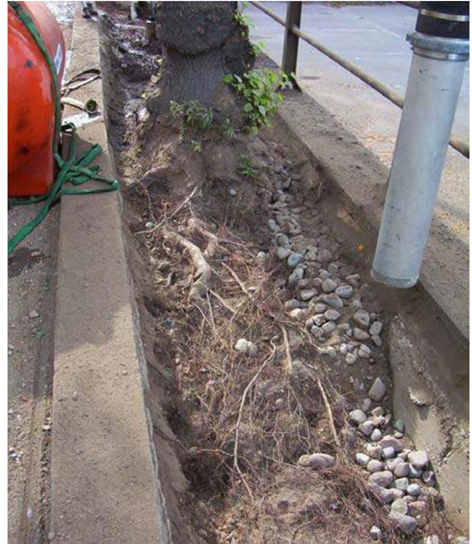
Rotvänlig schakt används här för att skonsamt ta bort överbyggnadsmaterial och blottlägga det befintliga rotsystemet. En tät matta av fint rotsystem tas fram innan återställning av växtbädd med luftig struktur kan återläggas. (Foton: Örjan Stål)
