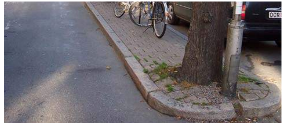
Befintliga lindar på Norrtullsgatan i Stockholm. Trädstammarnas möte med beläggningen vittnar om en uppfyllnad av marken kring träden. Trädens rötter har även lyft beläggning och kantstenar. (Foto: Björn Embrén)
