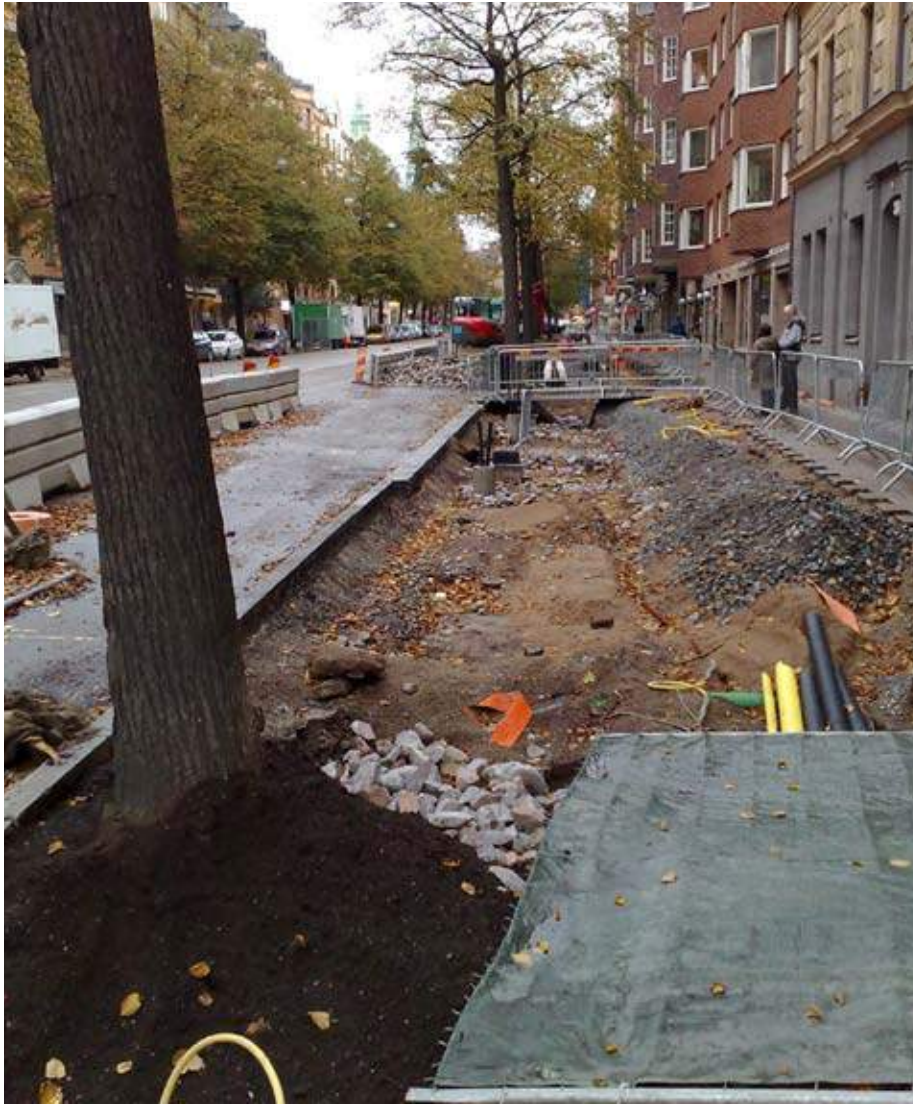
Schaktarbeten på Birger Jarlsgatan i Stockholm. Växtbäddsrenovering utförs i samband med byggnation av cykelbanor. Befintligt rotsystem skyddas mot uttorkning med utlagd växtjord. (Foto: Örjan Stål)
