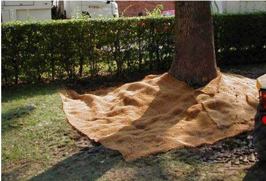
Skydd för frilagda rötter av kokosnät/juteväv. (Foto: Örjan Stål)
