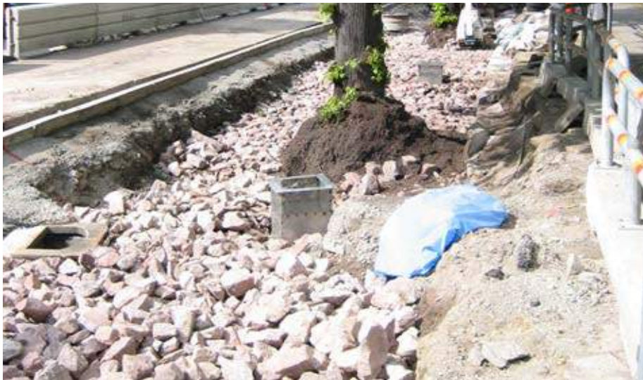
Befintliga gatuträd efter utförd schaktarbete. Utläggning av skelettskärv har påbörjats och luft- och dagvattenbrunnar har placerats ut direkt på skärven. (Foto: Björn Embrén)
