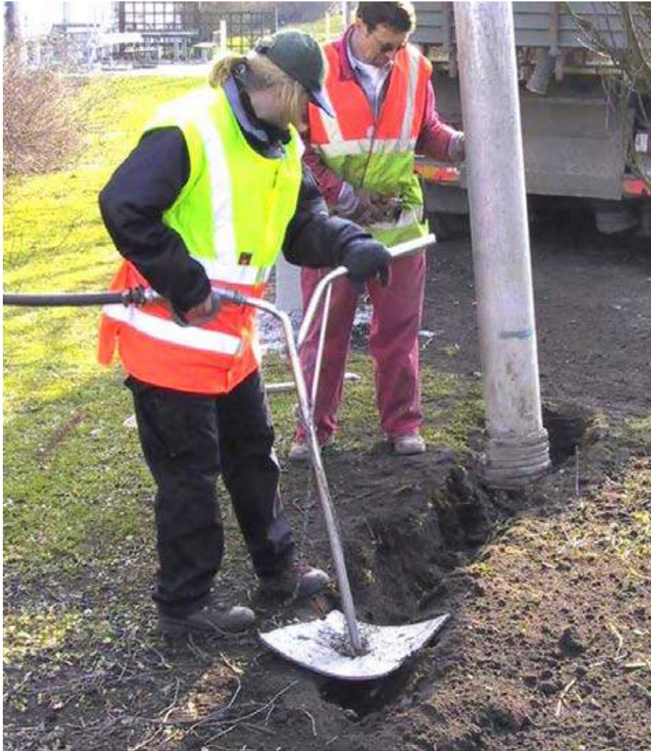
Arbete med vakuumteknik. Med tryckluftslansen skjuts jorden lös så att den sedan kan sugas upp. Tryckluftslansen används även för luckring av terrass och befintliga kompakterade jordtytor.
