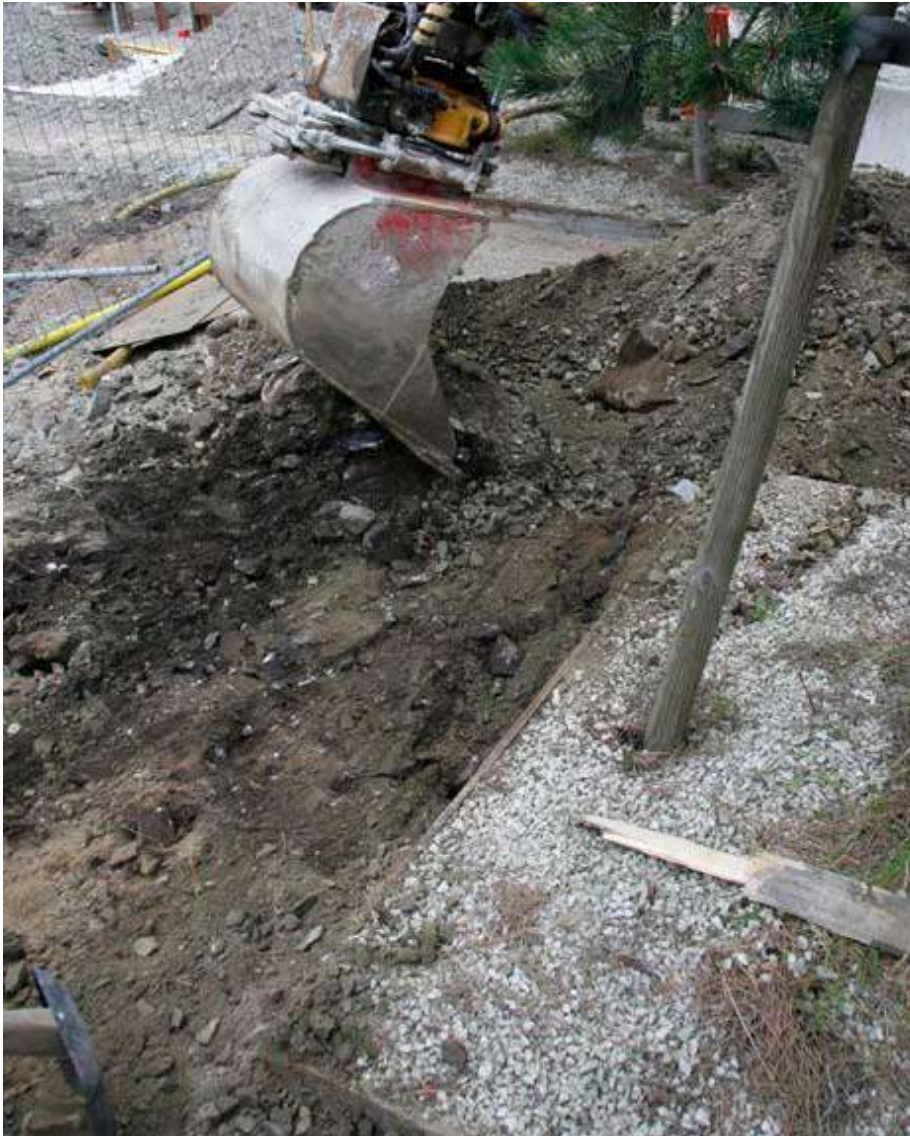
Maskinschakt och handschakt nära trädgrop i befintlig skelettjord. (Foto: Örjan Stål)
