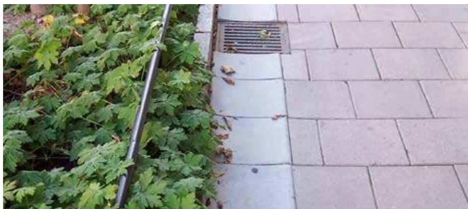
Bilden visar hur regnvatten från hustak leds via vattenutkast på fasad till luftbrunn placerad vid planteringsytan. Vattenrännan är lagd som lågpunktslinje med skålade betongplattor. Brunnen är en sk. luftbrunn och förser träden med såväl vatten som luft. (Foto: Björn Embrén)
