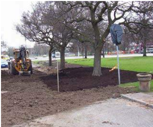
Utläggning av ny växtjord typ A i schaktgropen för gamla vägen. Ett nytt extra näringsrikt lager av mullrik växtjord läggs ut på det luckrade framschaktade rotsystemet. Slutligen färdigställande av ny sammanbunden parkyta med växtbäddsdrenerade ytor.
