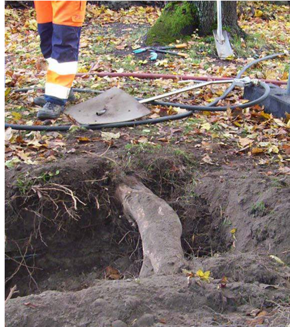
Träd kan i trånga situationer utveckla grova rötter, s.k. pipelines, vilka försörjer trädividen med en stor del av dess upptag av näring och vatten. Dessa rötter är viktiga att spara vid växtbäddsrenoveringar. Med vakuumteknik kan man schakta fram och kartlägga var dessa rötter går utan att skada rotsystemet. Vid traditionell maskinschakt finns en uppenbar risk att skada dessa grova rötter. (Foton: Örjan Stål)
