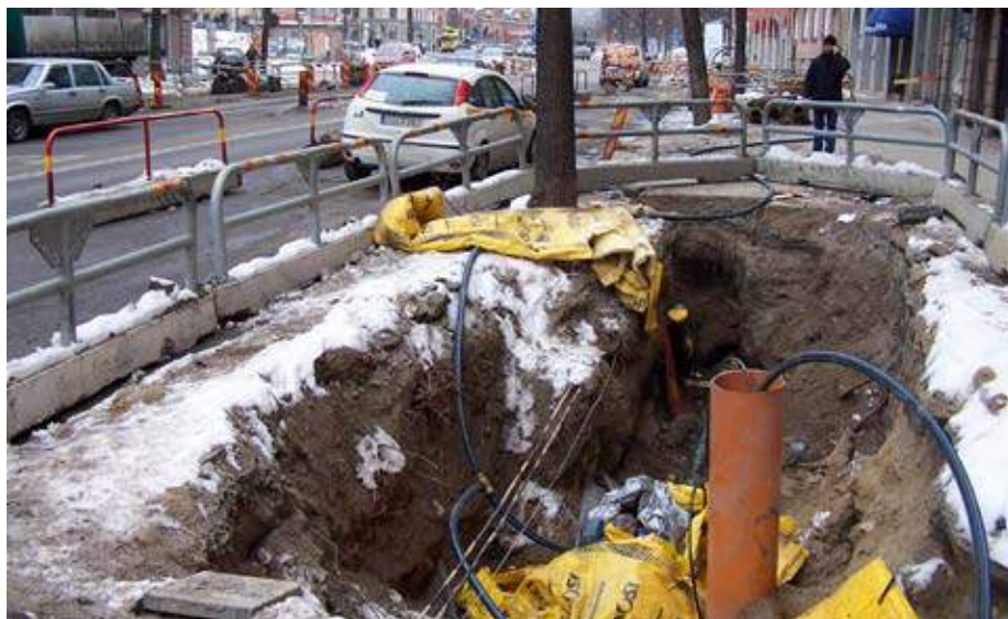
En nyschaktad gångbana nära en parklind på Birger Jarlsgatan i Stockholm. En vanlig marksituation för stadsträd där ledningsstråk och hårdgjorda ytor anläggs i trädets absoluta närhet. Trädet har utvecklat ett minimalt och kompakt rotsystem. Upprepade schakter och dåliga växtförutsättningar medger små utvecklingsmöjligheter i marken. (Foto: Björn Embrén)
